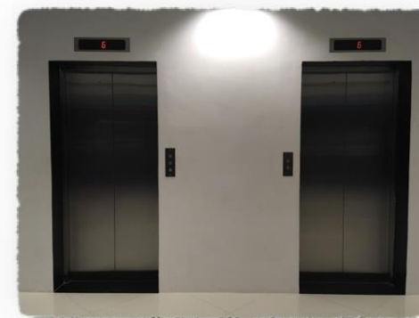
エレベーター
